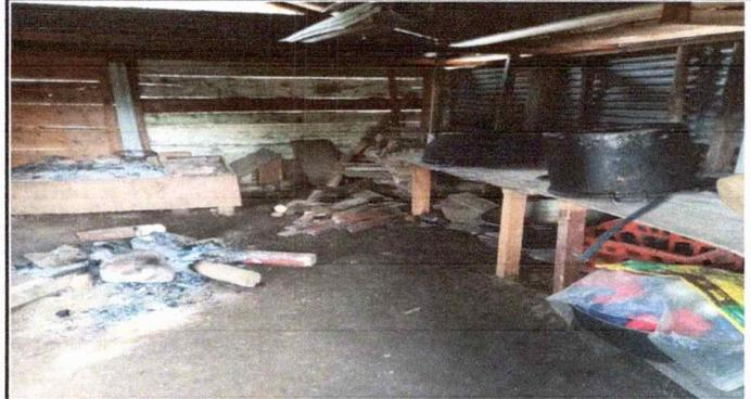
Se observa la falta de piso de torta de concreto.
