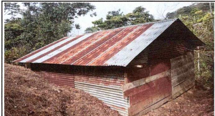
Se observa el deterioro de las laminas del techo de la cocina.
